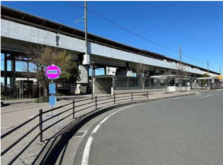
◀ 立体通路工事期間中の移動箇所
