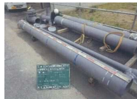
老朽管更新工事
