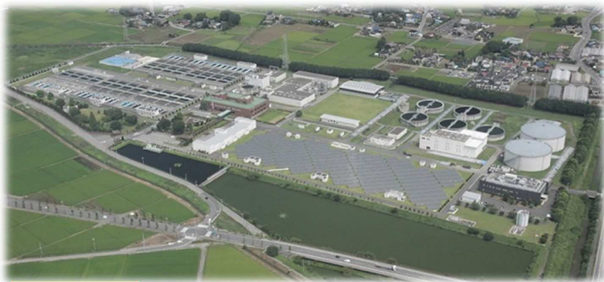
県営行田浄水場
