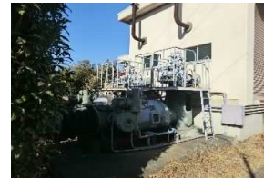
エンジン熱交換器の 工を行う 香日向排水機場
