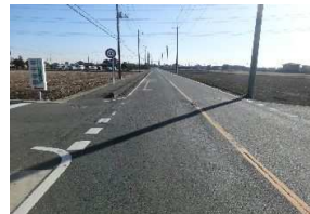
舗装工事を行う 市道1322号線
