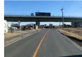
舗装工事を行う 市道1-1号線
