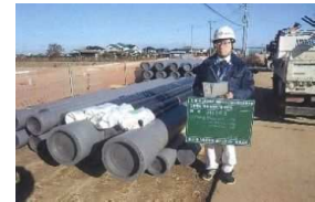
老朽管更新工事
