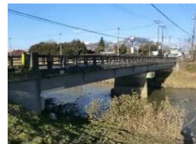
架換工事が行われる 上船渡橋
