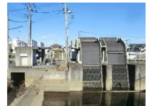
ポンプ交換工事を行う 第3ポンプ場
