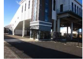
幸手駅東口の 公衆トイレ建設予定地
