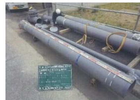
老朽管更新工事
