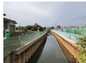
準用河川大中落の護岸工事完成箇所の状況
