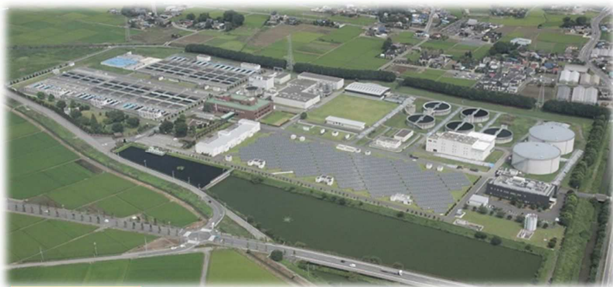
県営行田浄水場
