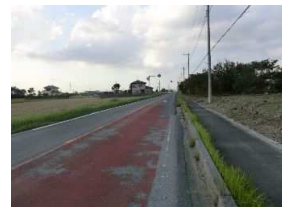
舗装工事を予定している 市道1-2号線
