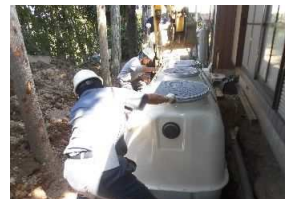
合併処理浄化槽設置費を補助します
