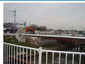
古川橋架替工事の様子
