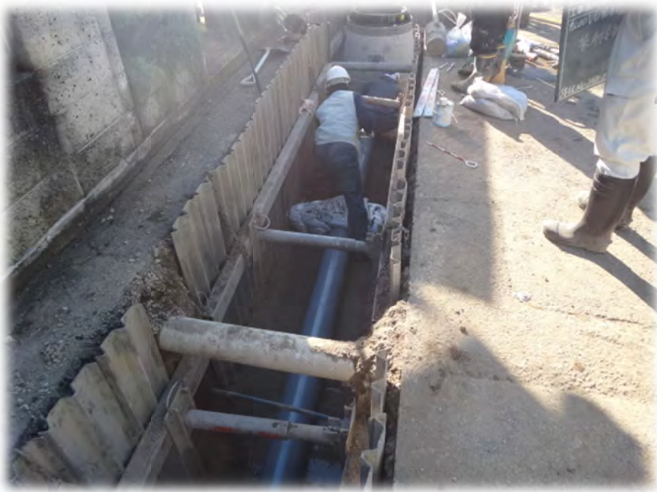
■ 下水道の工事
