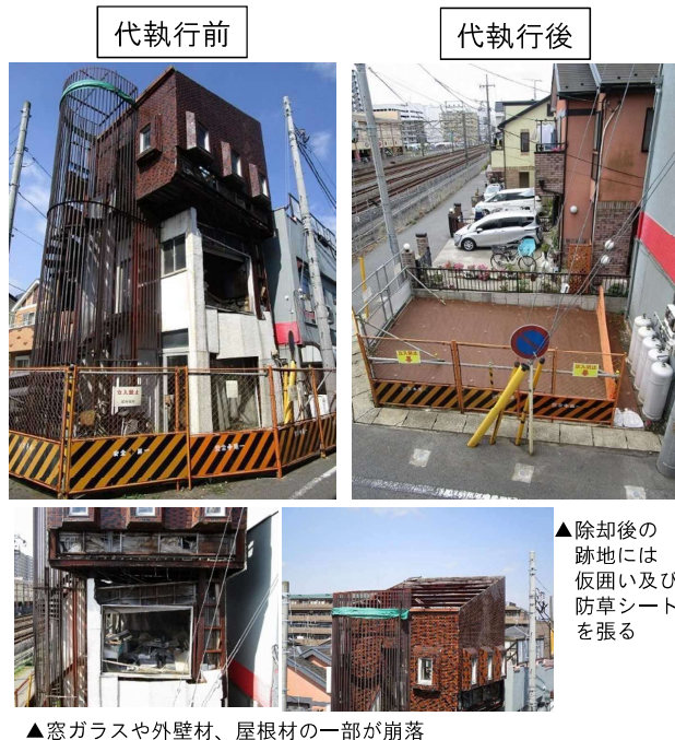
▲窓ガラスや外壁材、屋根材の一部が崩落
