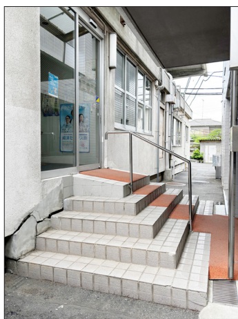
写真 1-4 第二庁舎への接続部
