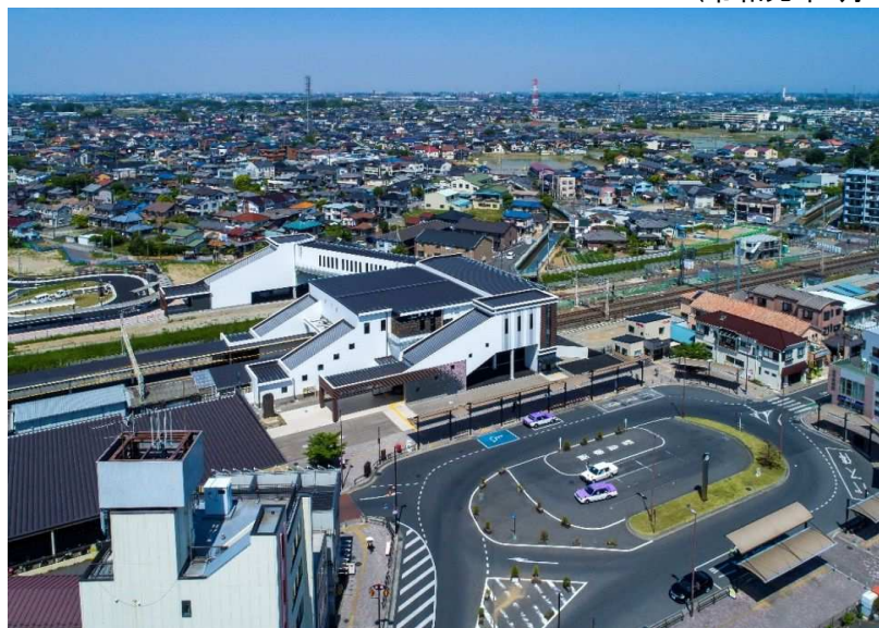
東西自由通路及び幸手駅舎の完成
