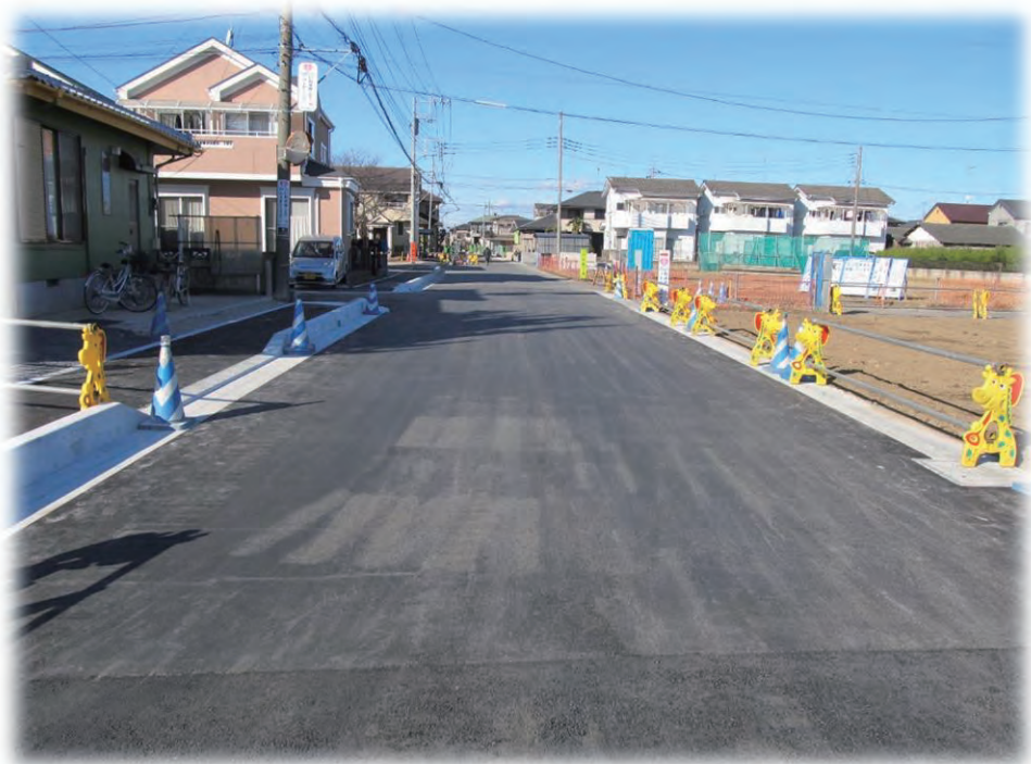
■ 幸手駅西口土地区画整理事業区域内の区画道路（整備中）
