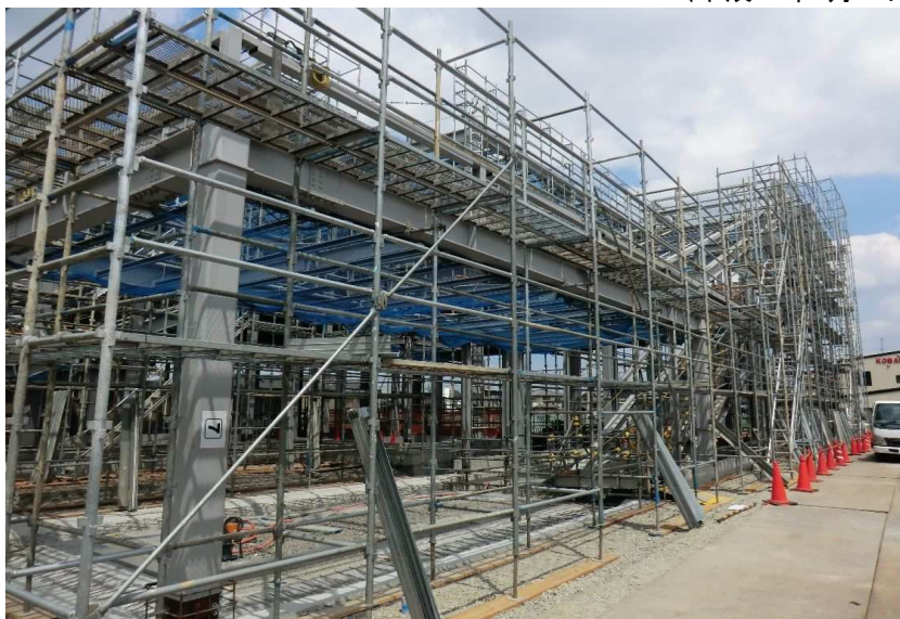
東西自由通路及び幸手駅舎工事の状況
