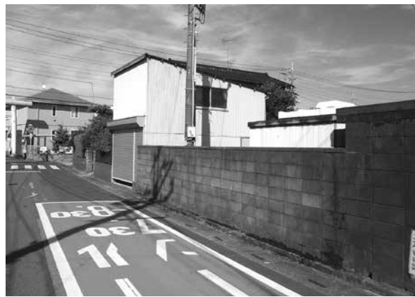
上高野小学校ブロック塀
