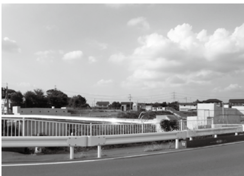
工事中の古川橋
