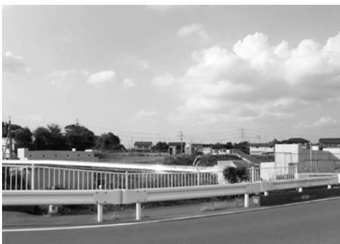
工事中の古川橋
