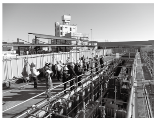
幸手駅の工事状況
