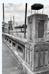
街中のランドマーク志手橋
