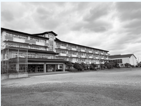
看護学校全景(旧香日向小校舎)
