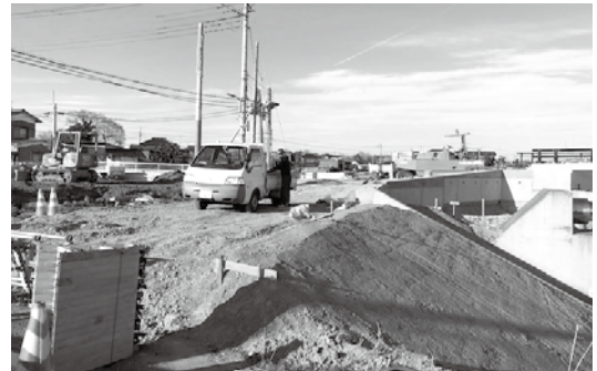
堤防からの取付道路工事
