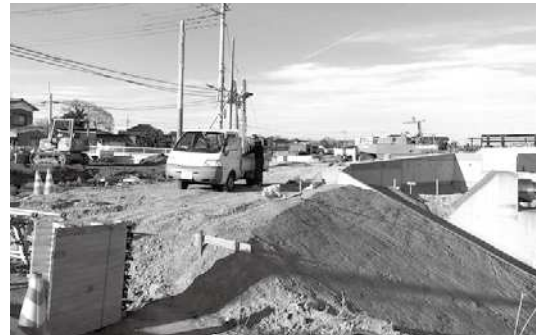
堤防からの取付道路工事
