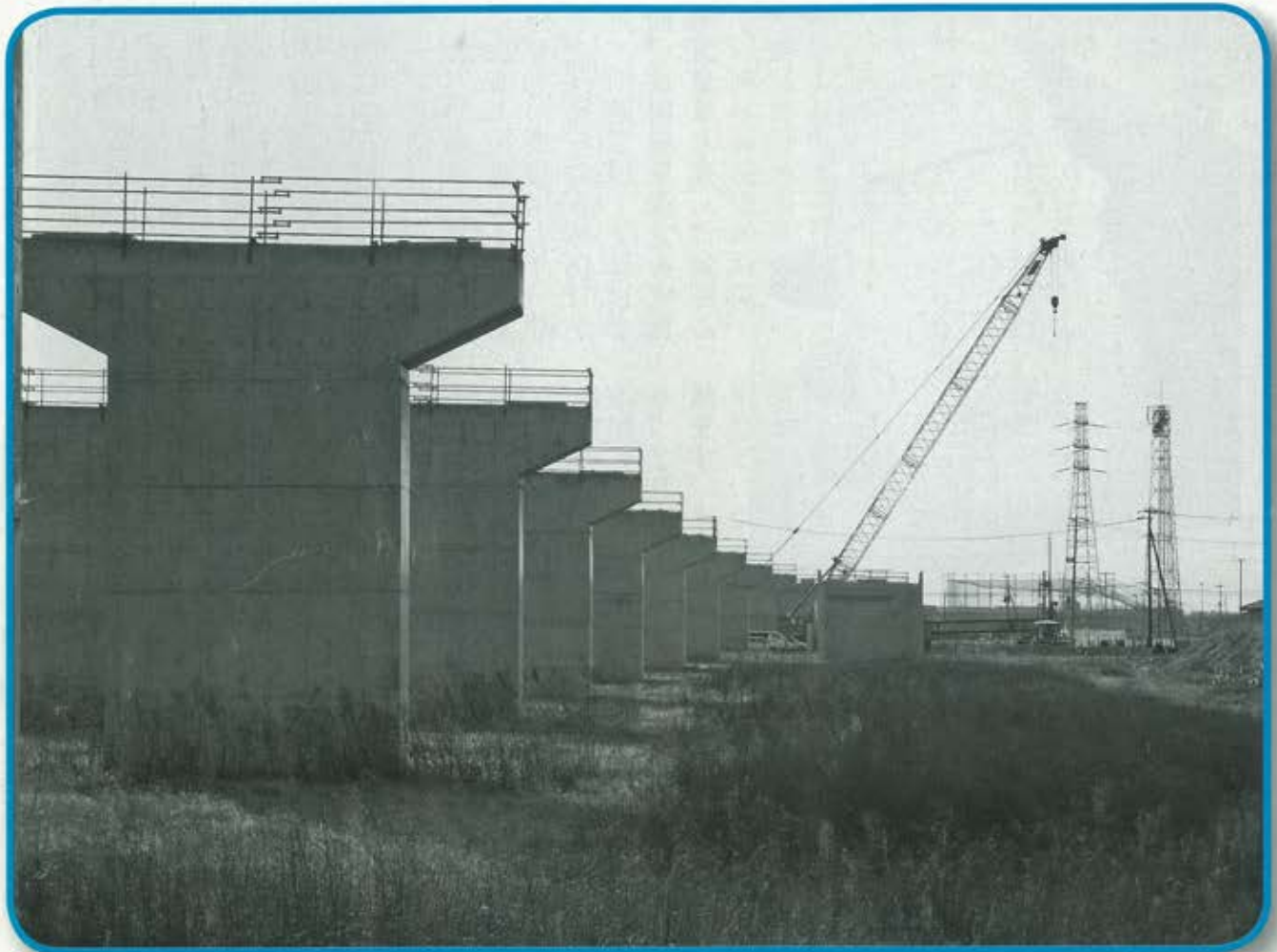
建設が進む圏央道(幸手インター付近)
