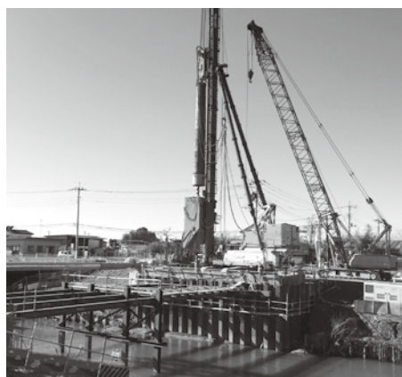
橋台工事の始まった古川橋
