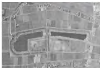
大島新田調節池
