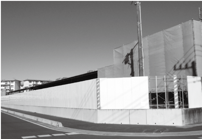
工事中の第二保育所
