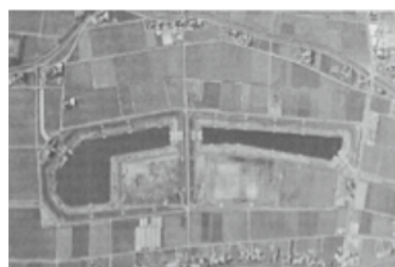
大島新田調節池
