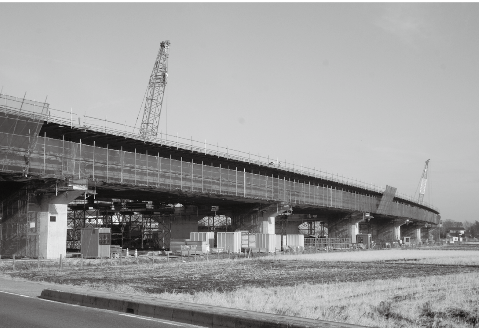
平成26年度中の開通に向けて工事が進む圏央道 ※写真は木立付近
