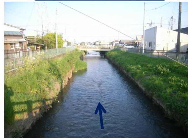
倉松川未整備区間 幸手橋（国道4号）上流
