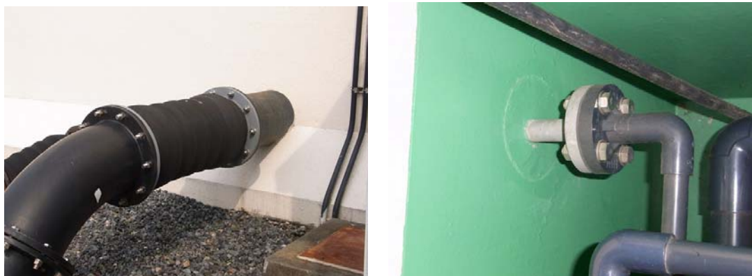
図 4-7 可とう管(左)、可とう管未設置(右)
