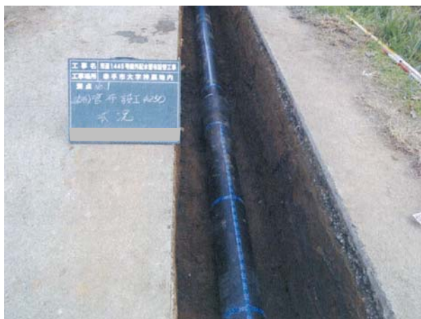
図 6-6 管路の布設工事の様子
