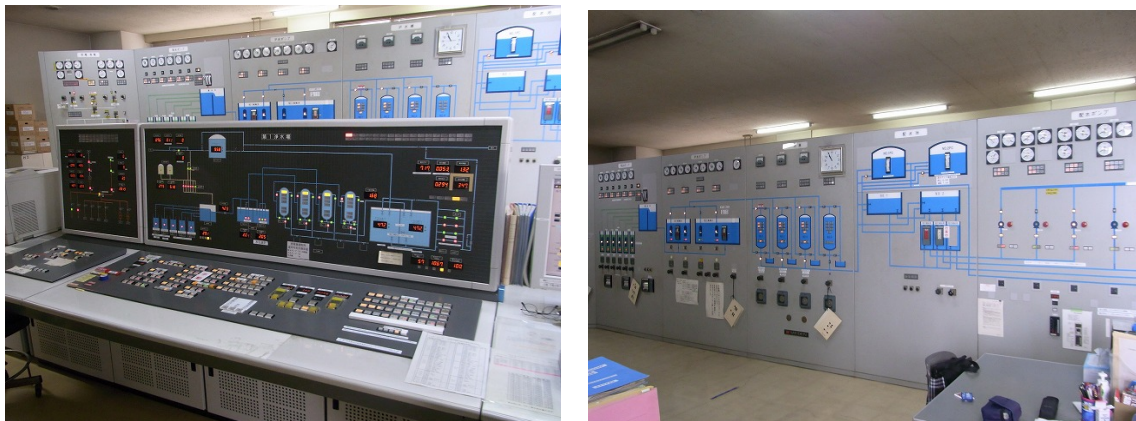
図 4-18 第2浄水場管理室内
