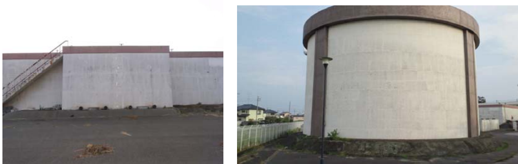
図 6-5 第1浄水場 RC 配水池(左上)、PC 配水池(右上)
