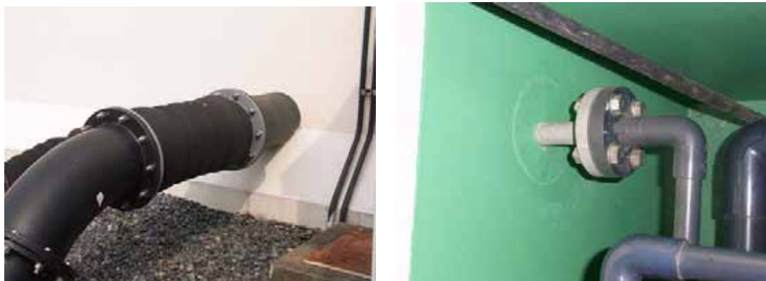
図 4-7 可とう管(左)、可とう管未設置(右)
