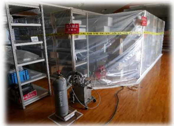
燻蒸ガス投入状況
