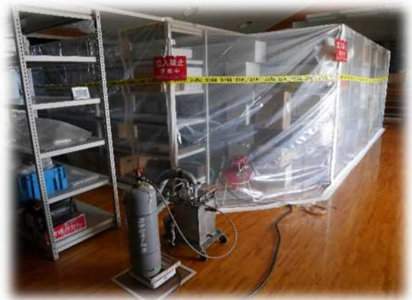
燻蒸ガス投入状況
