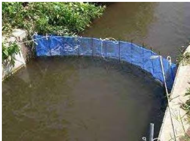
流出防止を目的とした網の設置例
