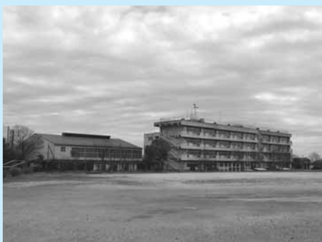
▲受け入れを予定している旧栄中学校跡地
