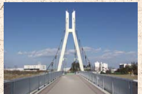
▲外野橋完成(平成15年)
