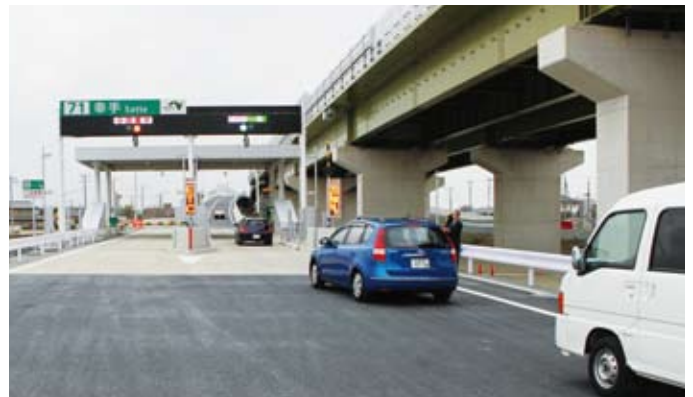
【圏央道幸手インターチェンジが開通】
