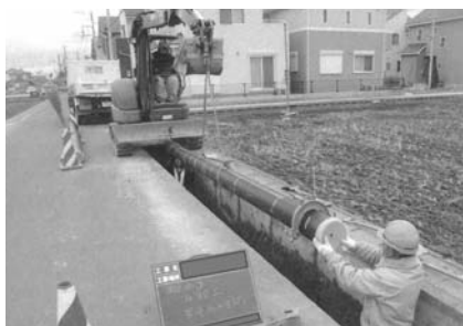
▲水道管更新工事の様子
