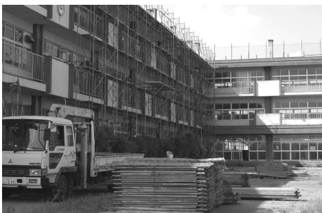
▲校舎改修工事の様子
