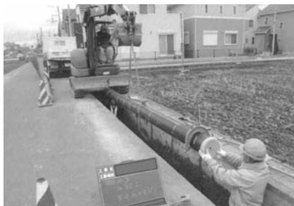
▲水道管更新工事の様子
