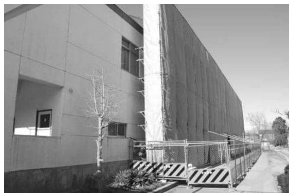
▲耐震化工事の様子
