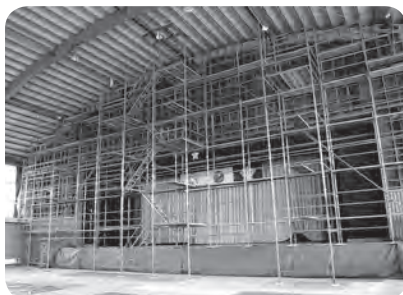
▲幸手中学校体育館内の工事の様子
