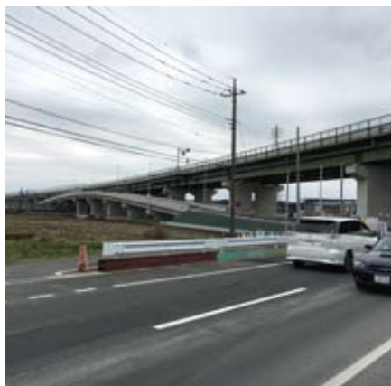
【道路網の整備】 圏央道幸手インターチェンジの開通に併せ、側道の整備を行いました（写真／上高野通り）。
