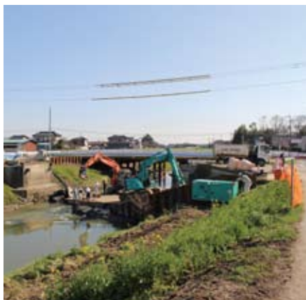
【計画的な橋梁の修繕】 市の東側を流れる中川に架かる老朽化した橋梁の計画的な修繕を行っています。
