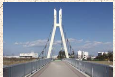
▲外野橋完成(平成15年)
