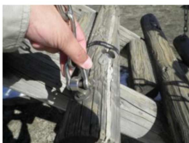
吊り金具の交換
