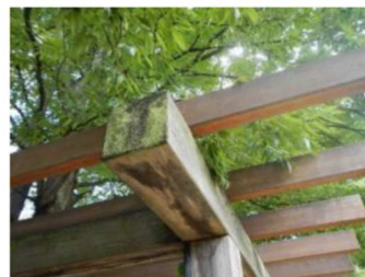
木部の防腐処理
