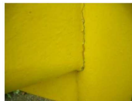
滑り台の破損
