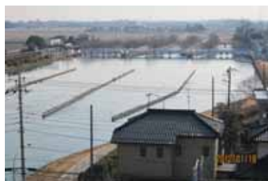
行田の大堰(利根川から取水)(5 つの水路に分水)
