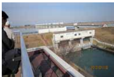
行田の大堰(利根川から取水)(5 つの水路に分水)
