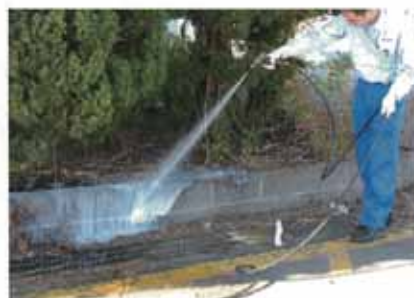
専門業者による液剤の高圧散布
