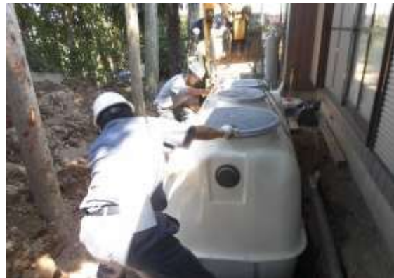
排水処理施設の整備(合併処理浄化槽工事)
