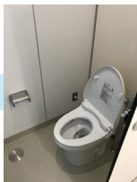
洋式便器（改修後）
