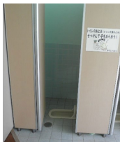
和式便器（改修前）
