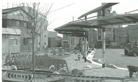
◀整備が進む駅前広場
