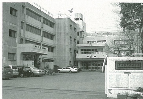
▲西中学校の改修
