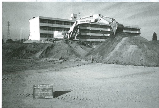
雨水貯留浸透施設の工事（写真は西中学校）
