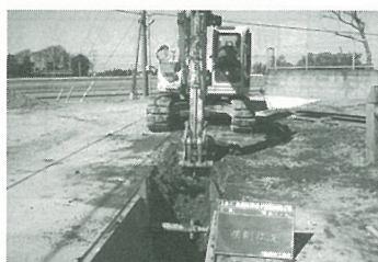
農業集落排水事業(農業集落排水工事)
