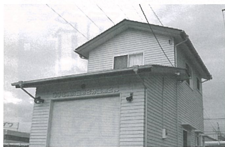
消防費 消防団機具庫の新築
