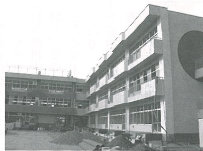
教育費 小学校改修工事
