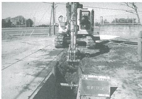
農業集落排水の工事を進めます
