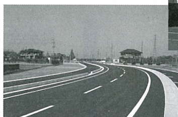
▼道路などの整備
